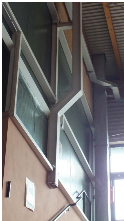
Figura 2 - baraccatura laterale - dettaglio profilo HEA160 di rinforzo presente sul lato Ovest
